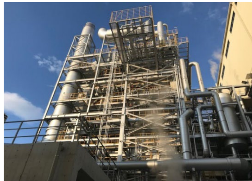
東三河バイオマス発電所
