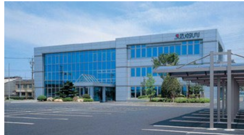
ZEB化改修工事を行った鈴木組本社ビル
