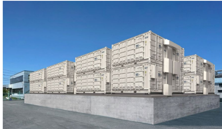
「サーラ浜松蓄電所」系統用蓄電池(コンテナ型NAS®電池)の概要と設置イメージ図
