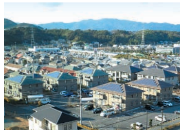
アパート14棟に太陽光発電システムを設置
