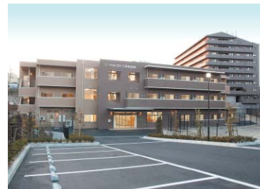
ベストライフ浜松和合新築工事 お客さまからの高い評価が確かな技術の証明です。
