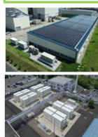
サーラ東三河太陽光併設蓄電所 (2025年10月開所)
