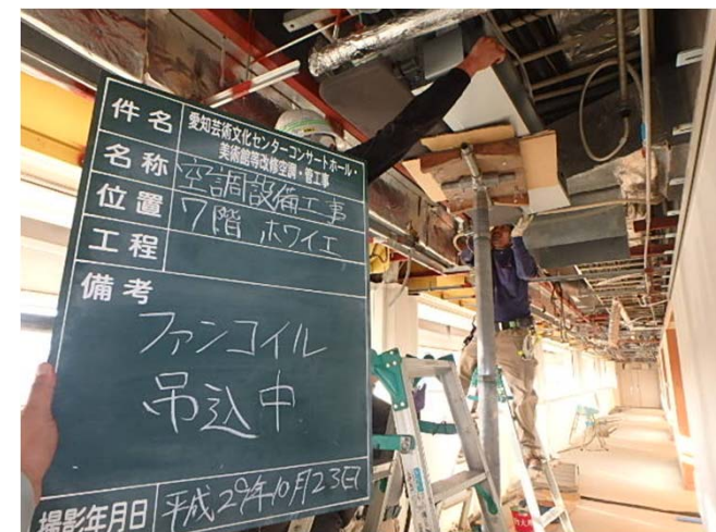
愛知県芸術劇場コンサートホールの空調工事
