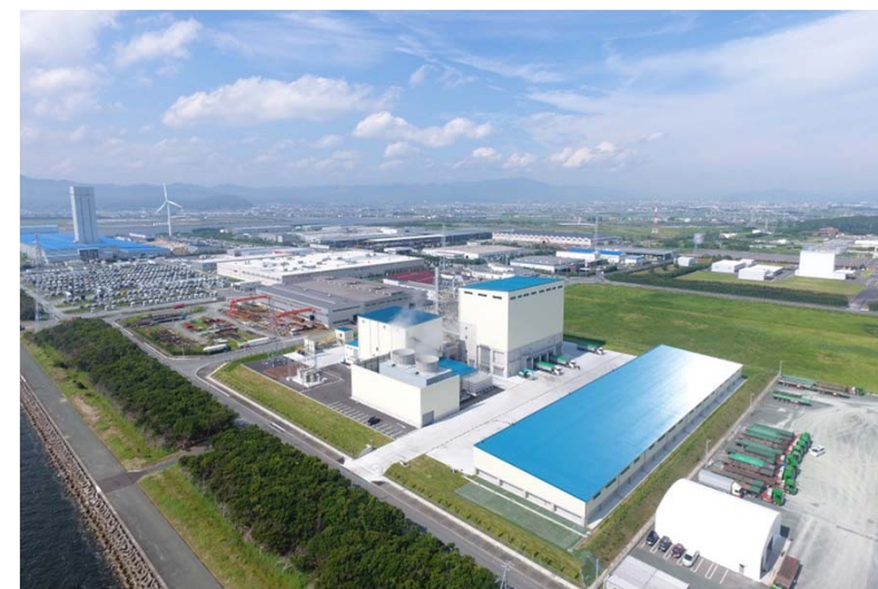
東三河バイオマス発電所
