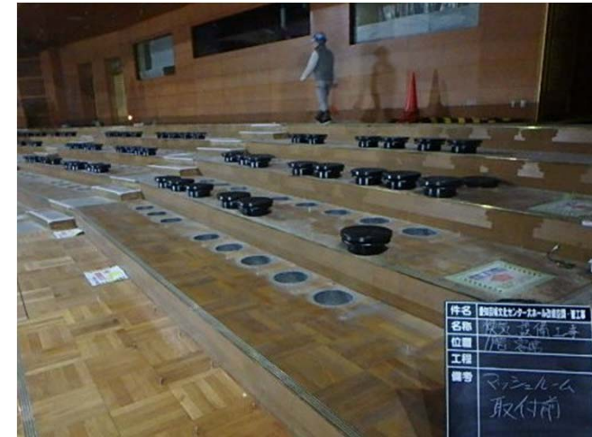
愛知県芸術劇場大ホールの空調工事
