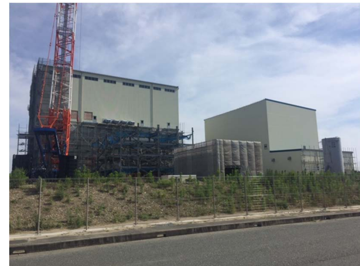
ボイラー架台工事
