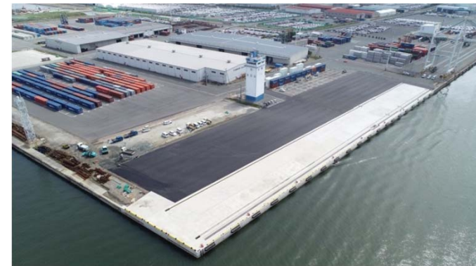
神野建設による三河港・神野地区岸壁改良工事 既存岸壁を200m延伸し、水深12mで耐震強化岸壁を整備
